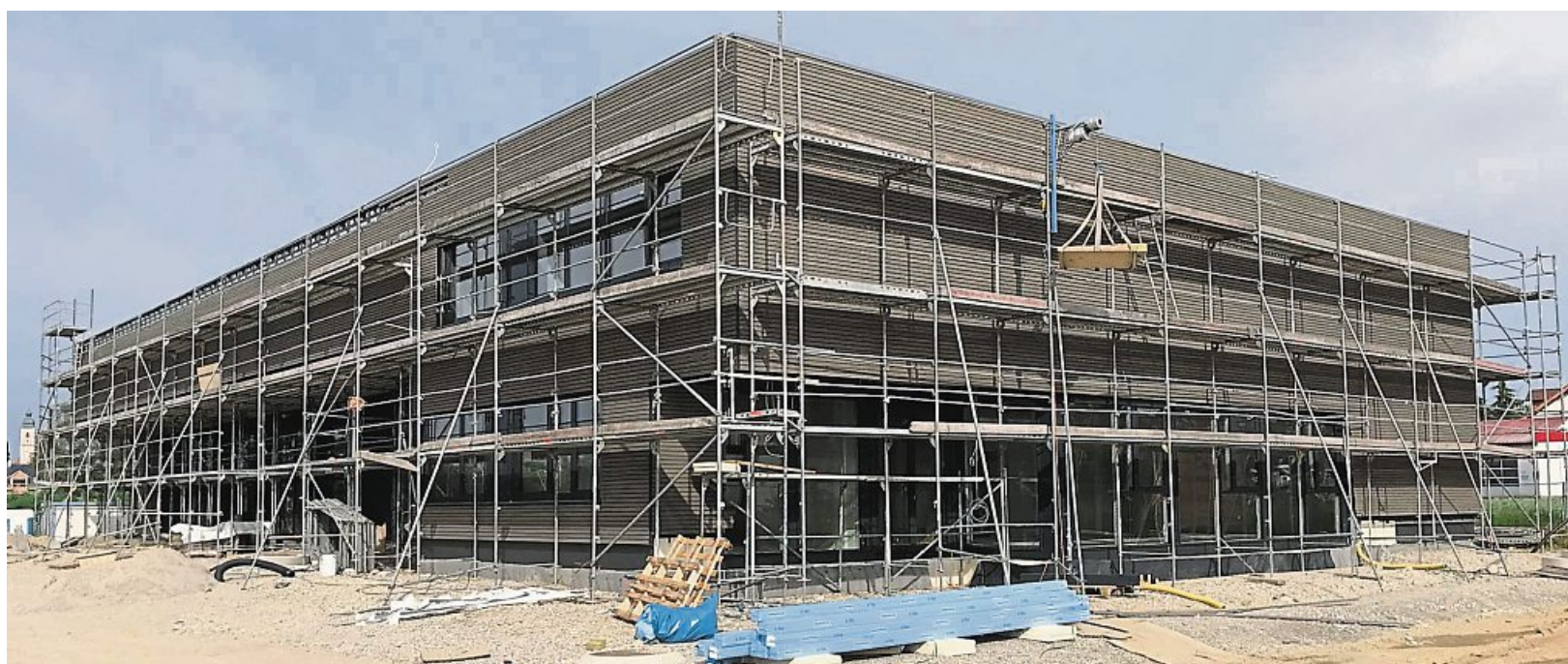
Der Rohbau des neuen Feuerwehrgerätehauses mit fünf Ausfahrten für alle Fahrzeuge steht. Foto: Vroni Macht
